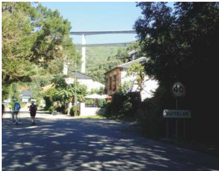
Camino večkrat poteka pod avtocesto. V Ruitelanu je avtocesta proti A Coruñi visoko nad glavo.
