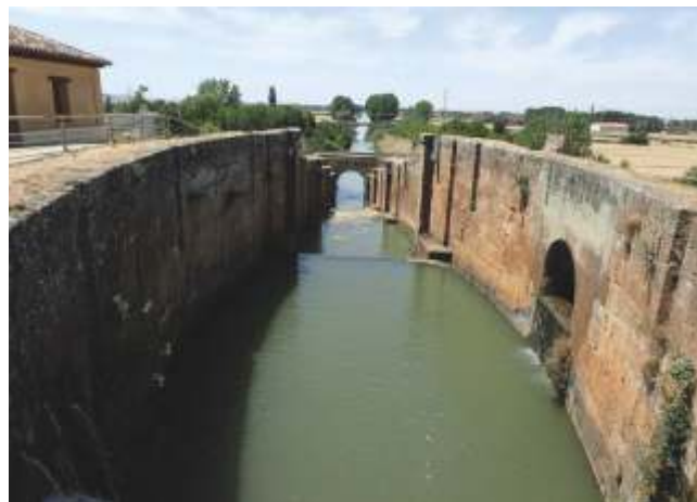
Pretočni kanal iz 19. stoletja pri Frómisti za dvigovanje ladij na nekdanji plovni poti za prevoz žita.
